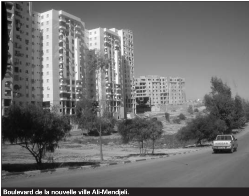
Boulevard de la nouvelle ville Ali-Mendjeli.
