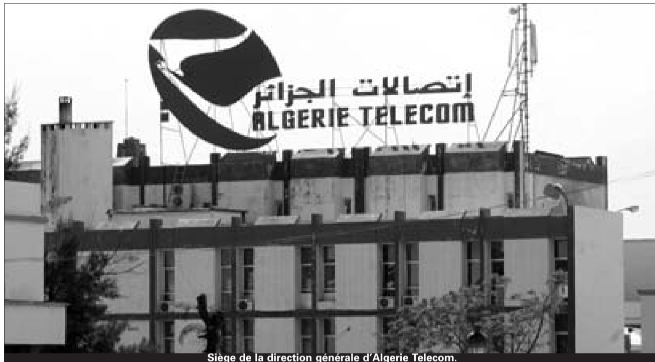
Siège de la direction générale d'Algérie Telecom.
