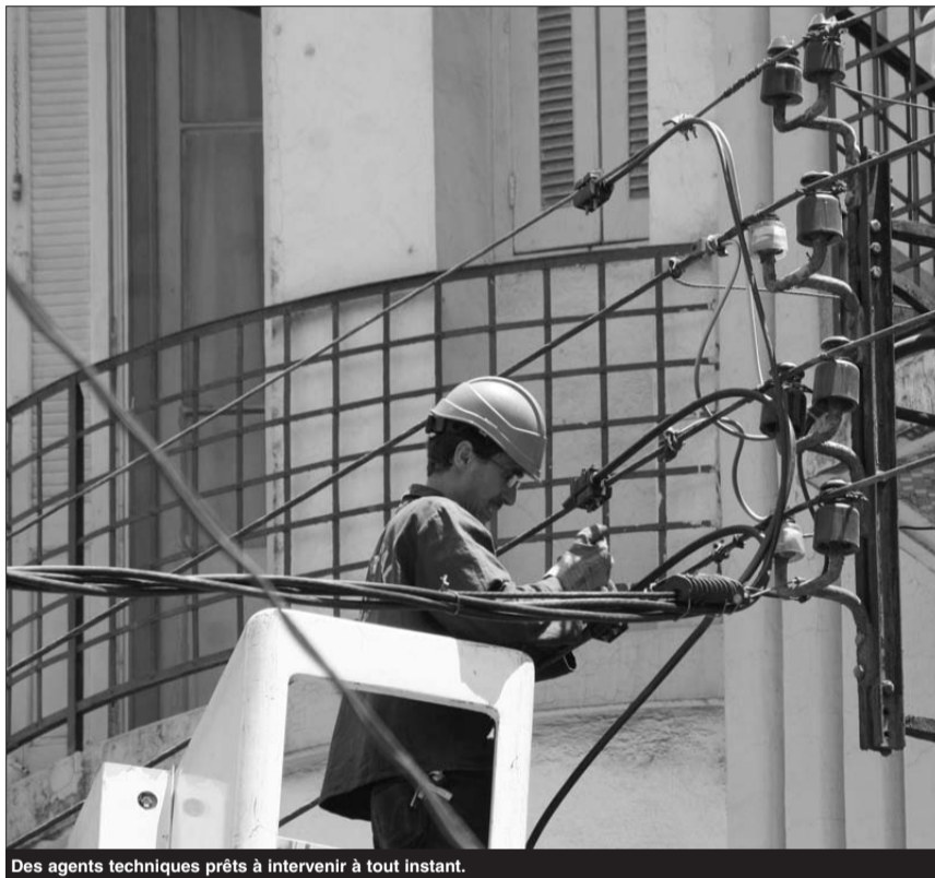
Des agents techniques prêts à intervenir à tout instant.
