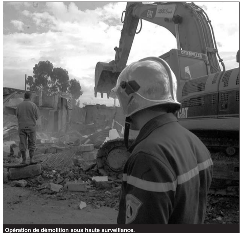
Opération de démolition sous haute surveillance.
