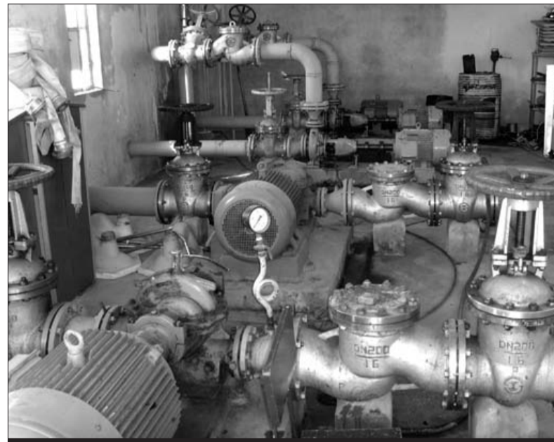
Des stations de pompage renouvées pour améliorer la distribution d'eau.
