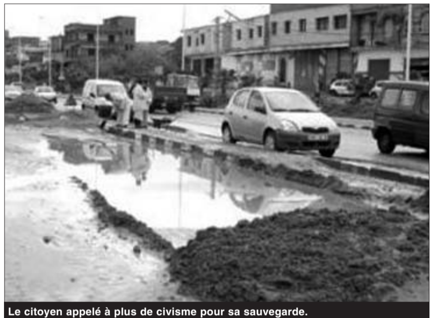
Le citoyen appelé à plus de civisme pour sa sauvegarde.
