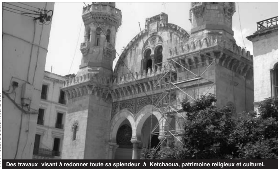
Des travaux visant à redonner toute sa splendeur à Ketchaoua, patrimoine religieux et culturel.
