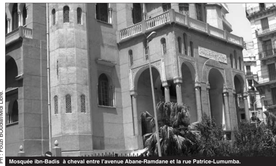
Mosquée ibn-Badis à cheval entre l'avenue Abane-Ramdane et la rue Patrice-Lumumba.
