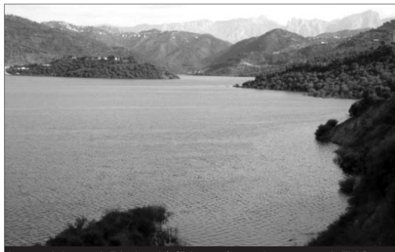
Les eaux du barrage de Taksebt ne bénéficient pas à toutes les communes de Tizi Ouzou.
