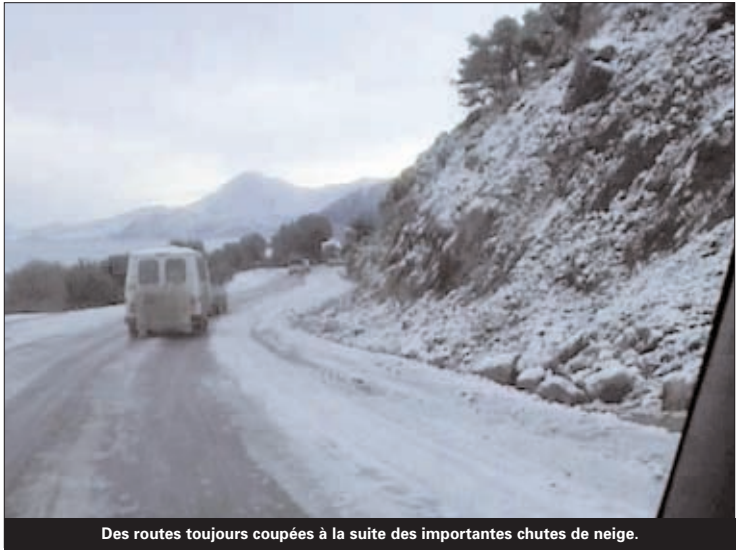
Des routes toujours coupées à la suite des importantes chutes de neige.
