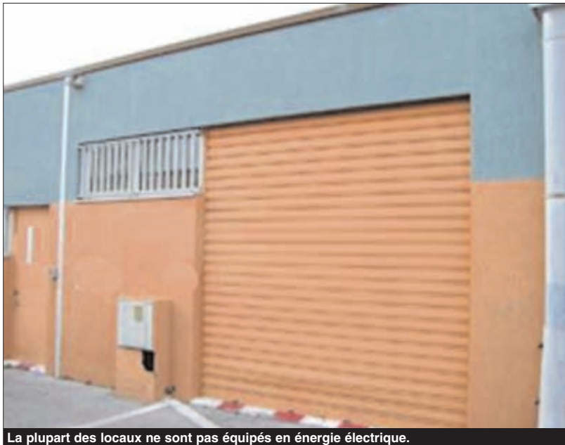
La plupart des locaux ne sont pas équipés en énergie électrique.
