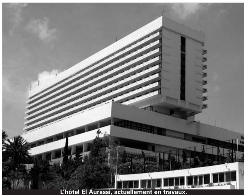
L'hôtel El Aurassi, actuellement en travaux.
