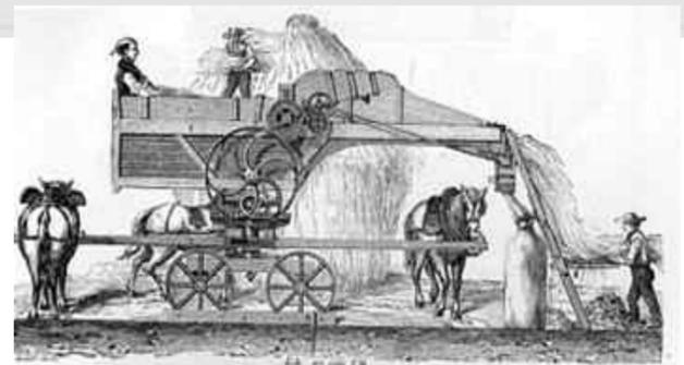
Fig. 114. — Battage mécanique à manège direct pour les batteurs.
