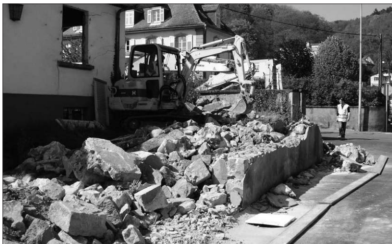
L'opération de lutte contre les constructions illicites est bel et bien lancée.
