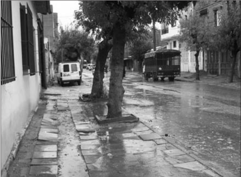
Souvent refaits, les trottoirs ne tiennent pas le coup !
