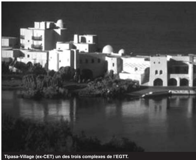
Tipasa-Village (ex-CET) un des trois complexes de l'EGTT.
