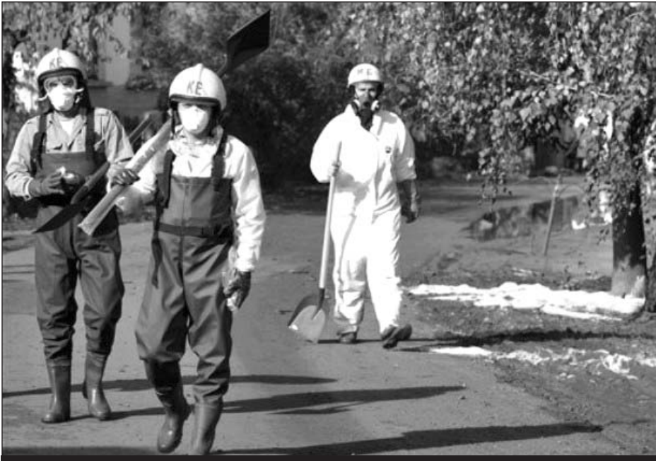
Les autorités hongroises ont lancé des travaux d'assainissement dans la zone affectée.
