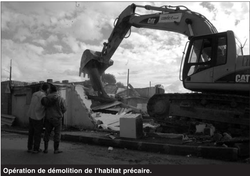
Opération de démolition de l'habitat précaire.
